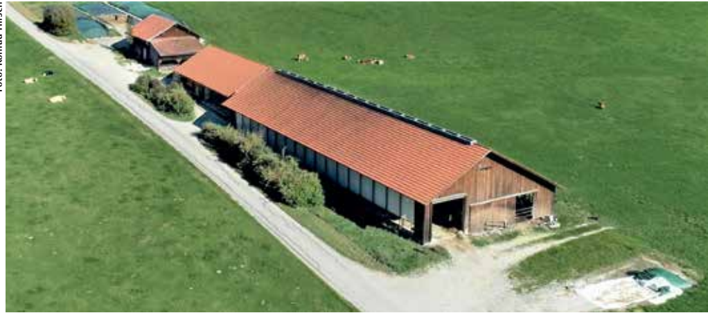
Es gibt wunderbare Kuhställe aus eigenem, nicht getrocknetem, ungehobeltem Holz, das auf der Baustelle abgebunden wurde.
